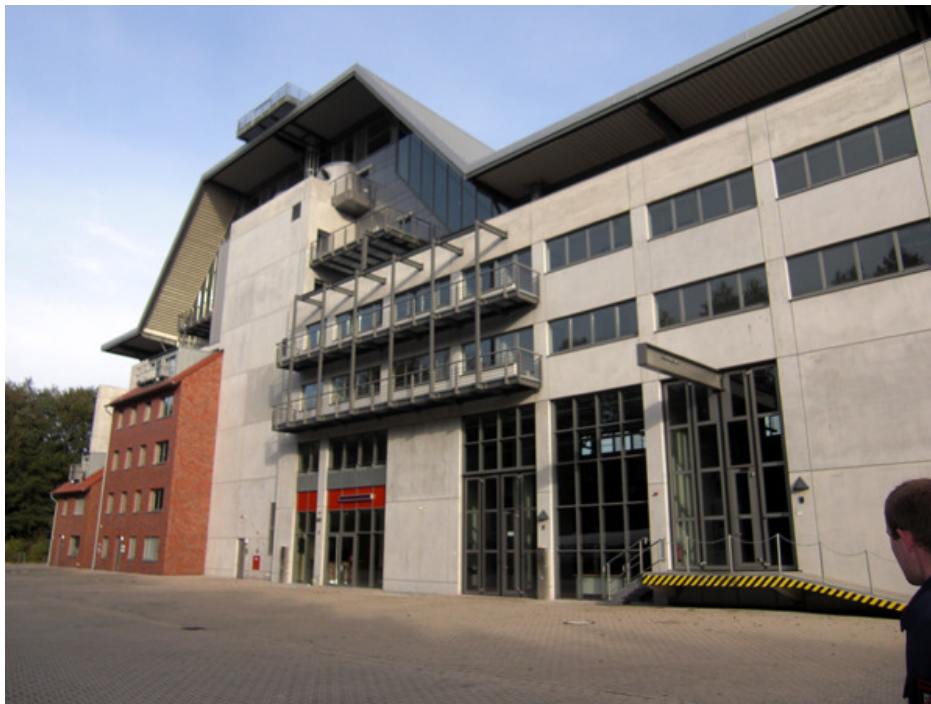
Die neue Übungshalle auf dem Gelände des Instituts der Feuerwehr in Münster.
