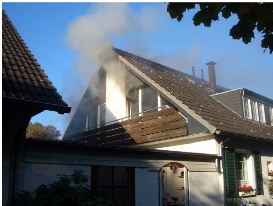
Rauchentwicklung aus dem Brandhaus Gerhardstraße
