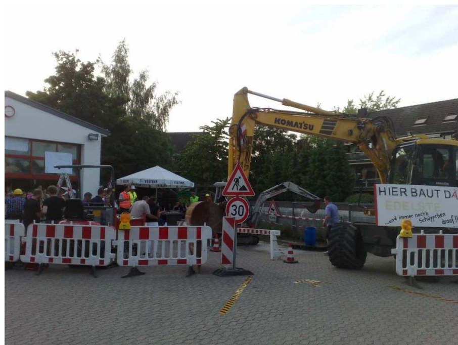
Garagenfest Motto Baustellenparty
