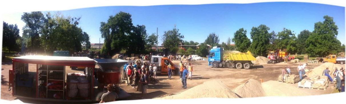
Sandsackfüllanlage im Einsatz beim Hochwasser
