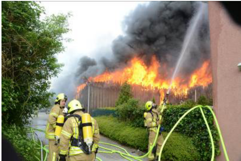
Kühlen der benachbarten Gebäude
