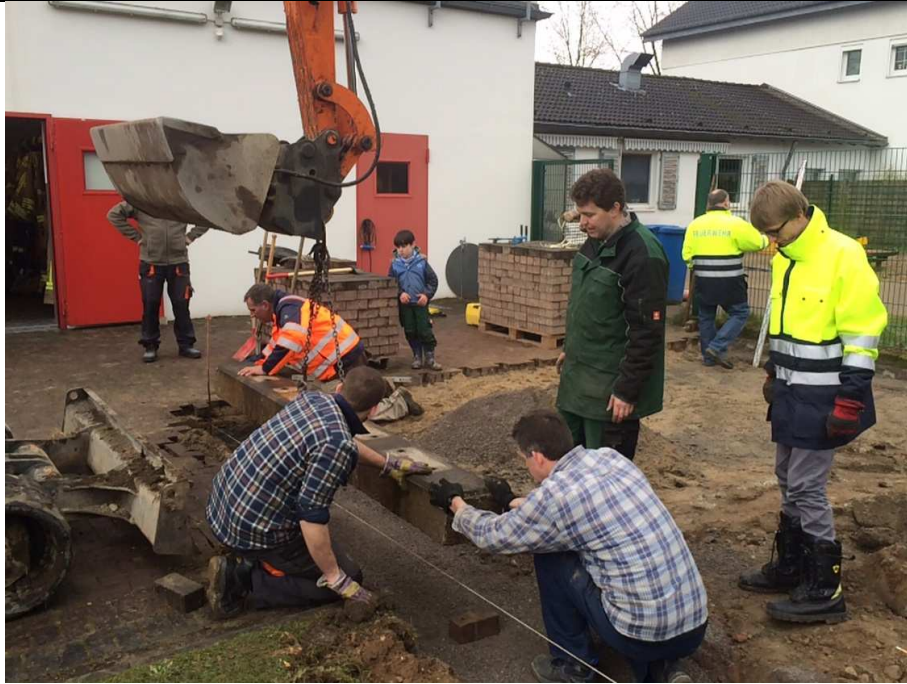
Vorbereitung des Fundamentes
