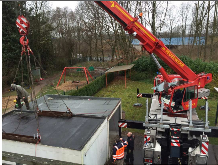
Die zweite Garage schwebt ein! Passt! Fertig!
