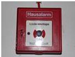
Nichtautomatischer Melder zur Auslösung der Hausalarmanlage ohne Alarmierung der Feuerwehr
